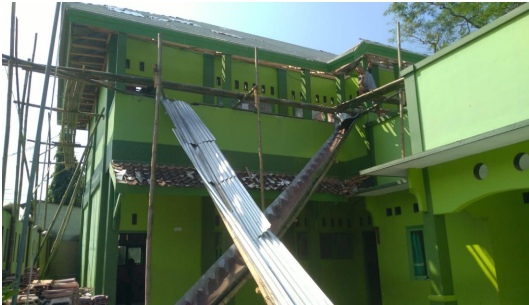
Gambar 4.17 Sarana dan prasarana gedung yang di renovasi MIN 1 Purbalingga
