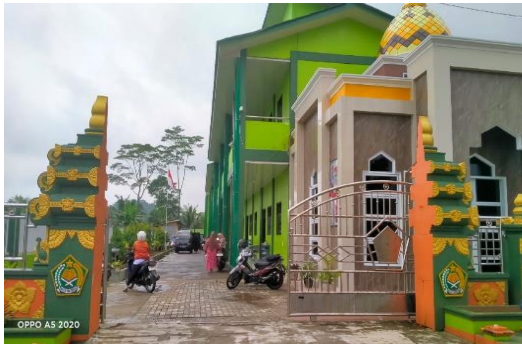
Gambar 4.4 Dokumentasi Azwar Usman Kondisi Fisik Gedung 3 Depan pintu Gerbang
