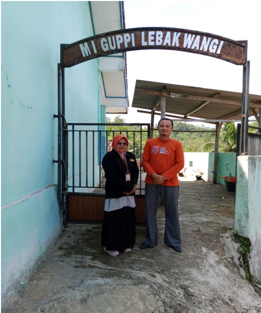
GAMBAR TAMPAK DEPAN GEDUNG MI GUPPI LEBAKWANGI
