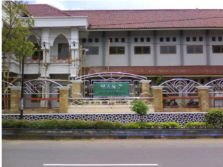
Papan nama Madrasah dan gedung tampak depan
